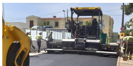
Asfaltatge carrers de Tres Cales.
